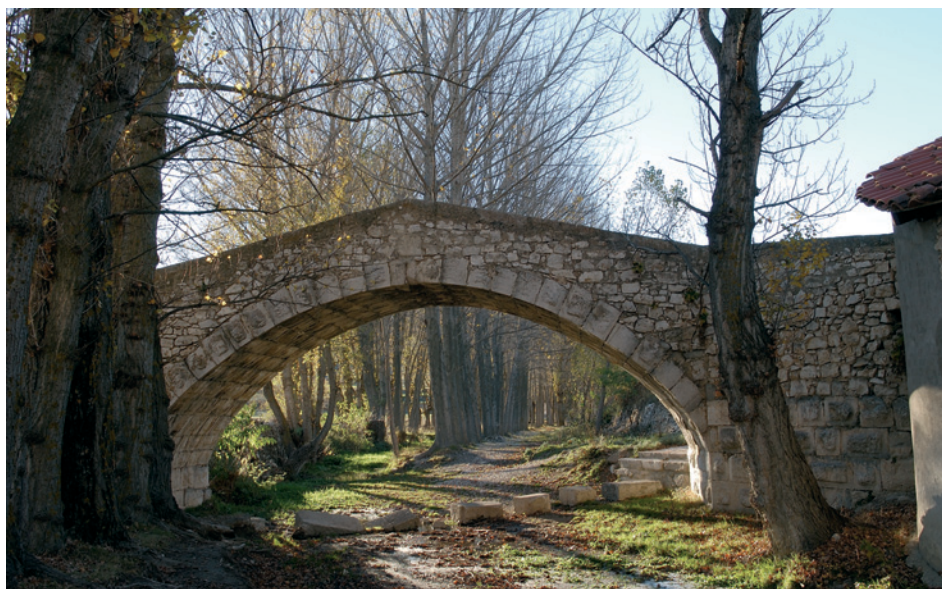
Puente de Fortanete
