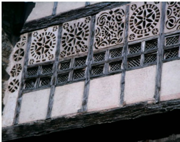
Ilustración 3. Detalle de una construcción con celosías en el centro de interpretación del patrimonio arquitectónico del Maestrazgo en Mirambel.
