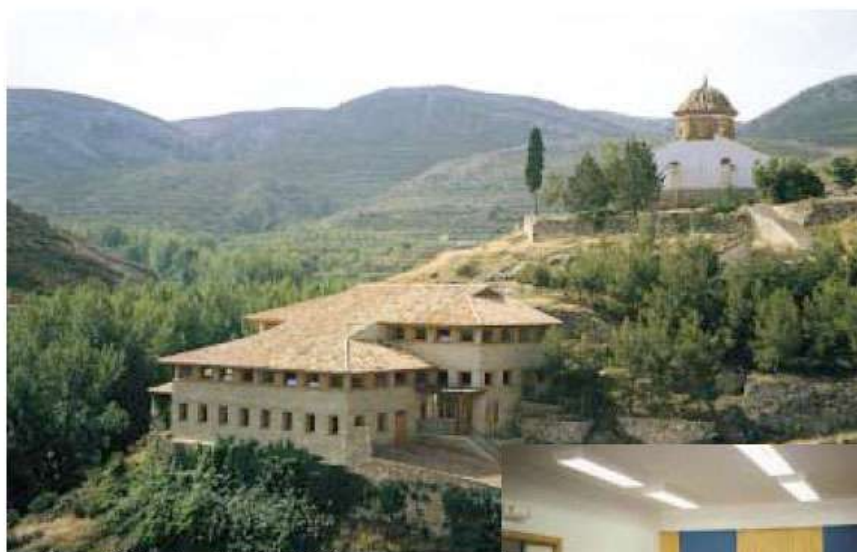
Instalaciones del Cedemate en la localidad de Molinos.
