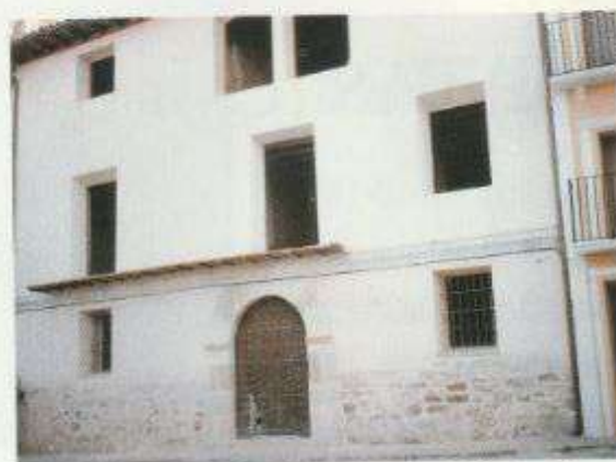
Fachada en restauración de la casa Feliu-La Figuera.
