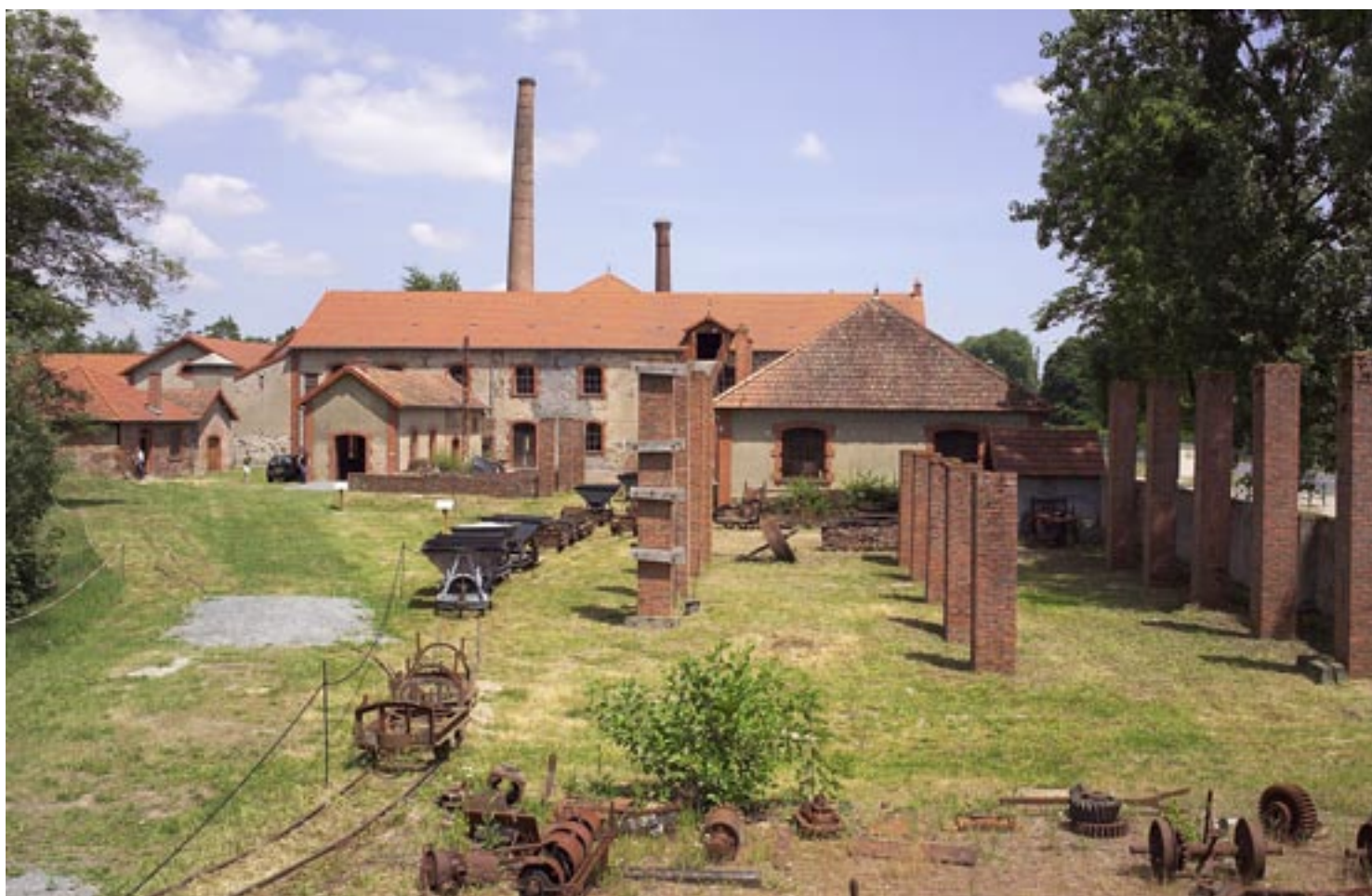
Vista general de la Briqueterie de Ciry de Ciry-le-Noble, antigua fábrica de ladrillos, cerca de Montceau, donde un taller de inserción ha permitido formar a varias decenas de profesionales de la construcción y restaurar una fábrica histórica que se ha convertido en punto de referencia del ecomuseo de la industria cerámica, 2005. Documento Écomusée Creusot Montceau/Cliché Daniel Busseuil.
