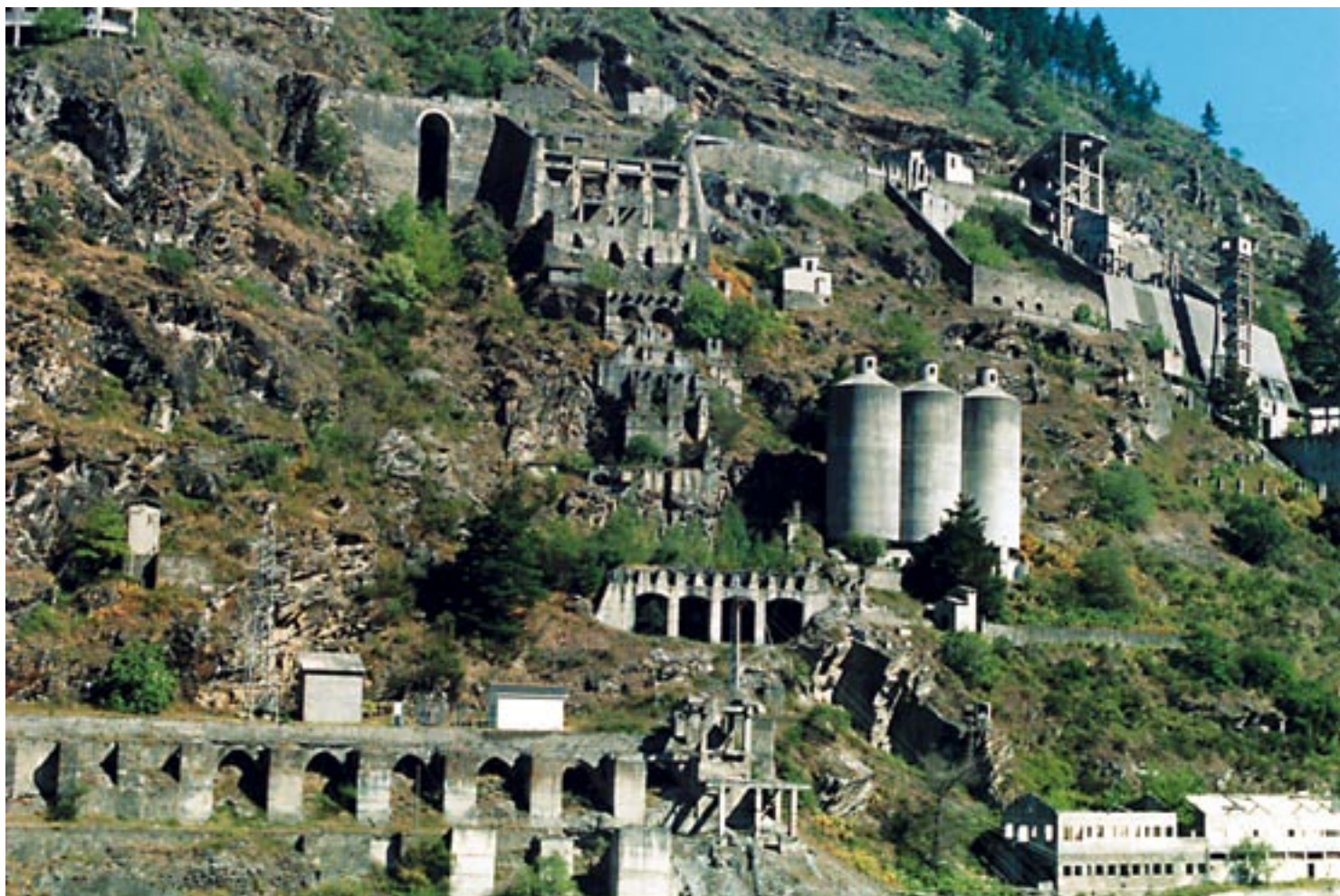
Restos industriales en la central de Salime, construida en los años 50 con proyecto de Vaquero Palacios.
