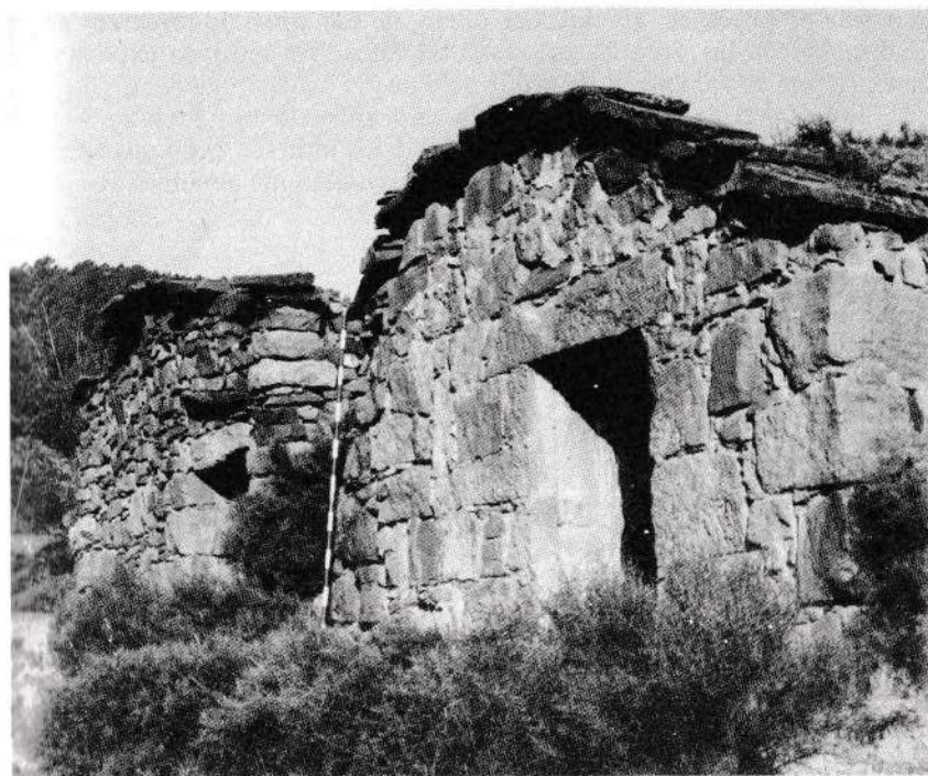
Fig. 8. Caseta abovedada B-1 (derecha) y caseta M-3 (izquierda)
