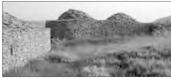
Mosqueruela. Caseta con dos falsas cúpulas por aproximación de hiladas.
