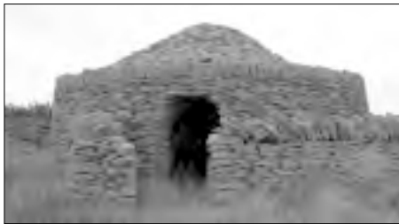
Iglesuela del Cid. Caseta con falsa cúpula por aproximación de hiladas dentro del Conjunto incoado BIC.
