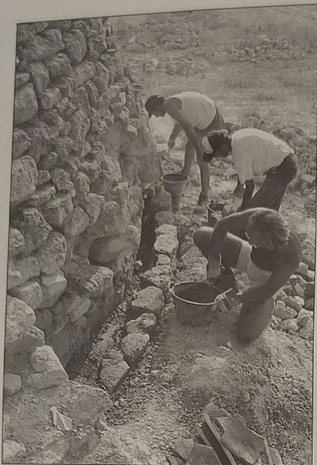
Trabajos de restauración en la nevera del Calvario, Fuentetodos, Zaragoza (agosto del 98). Foto: José Luis Ona.
