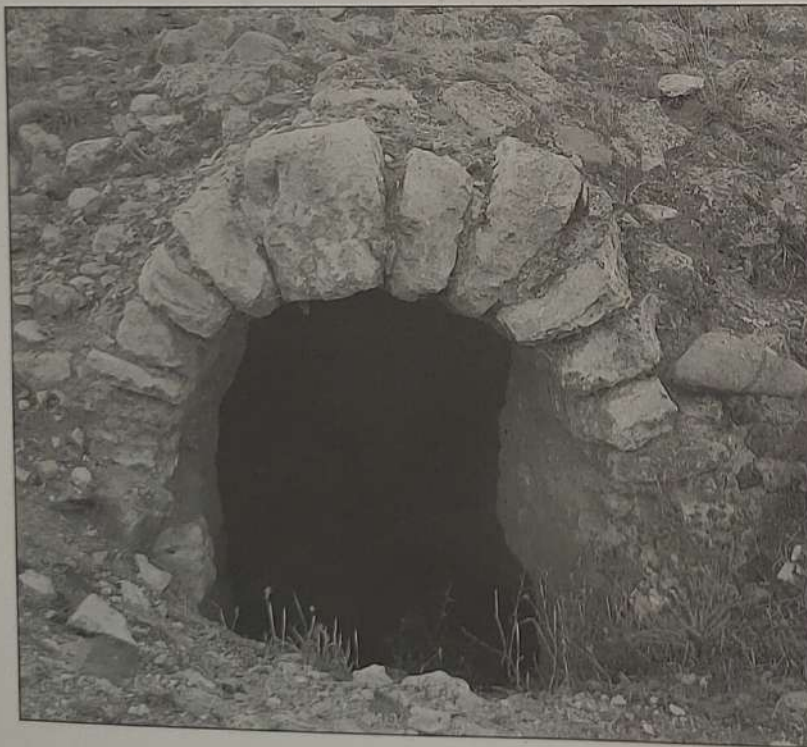
Detalle de la entrada de la nevera de Azuara, Zaragoza (julio del 98). Foto: José Luis Ona.
